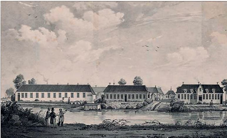
Gezicht op de achterzijde van het bedelaarsgesticht 'De Ommerschans'. Het is in 1819 opgericht als onvrije kolonie voor bedelaars, landlopers en onwilligen.
