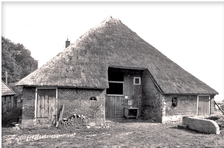
Boerderij De Poterijen aan de Middendijk in Nijbroek heeft nog een onderschoer.
