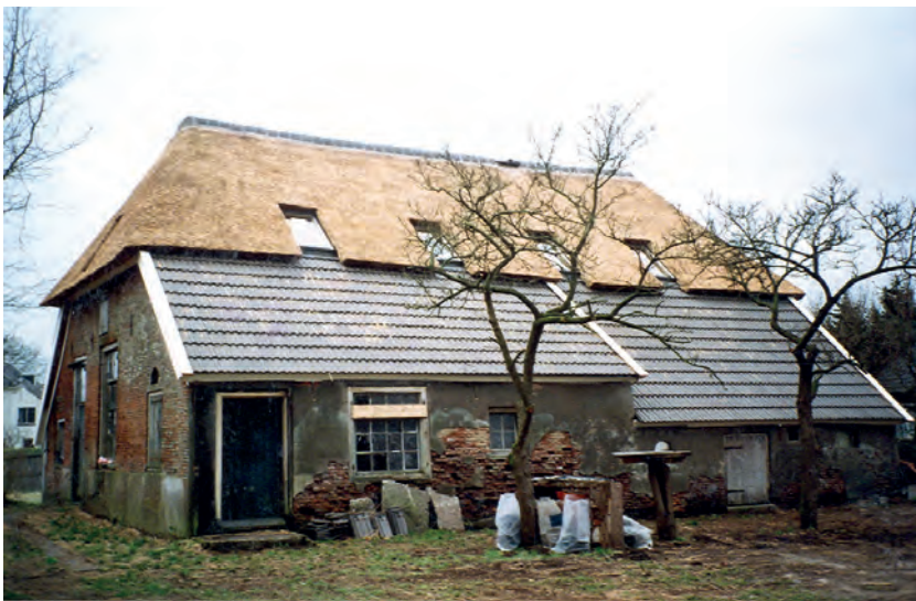
De Polmate tijdens de verbouwing. Het dak is klaar, nu de rest.
