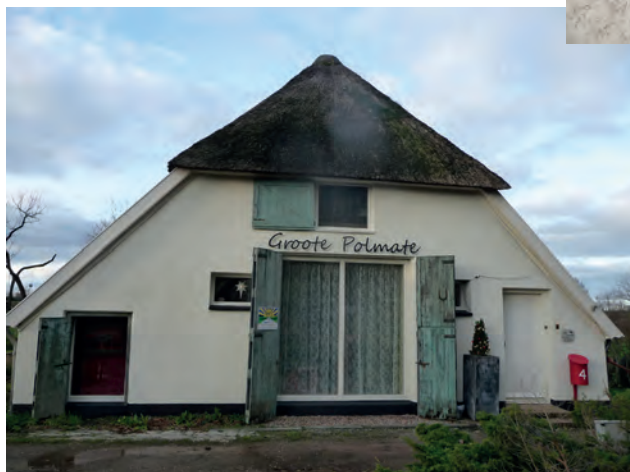
De Polmate na de restauratie
