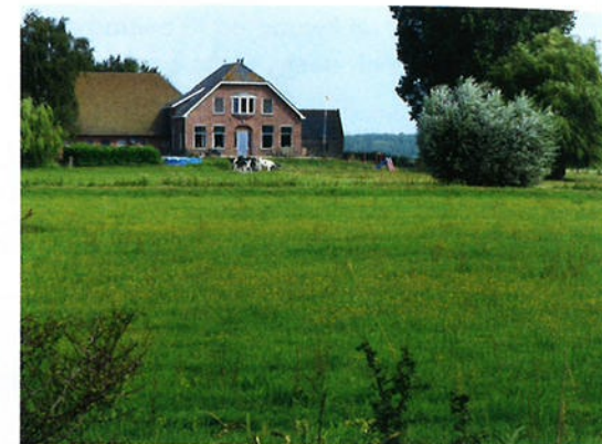
De Steunenbergh aan de Middendijk aan de zuidgrens van de polder Nijbroek is gebouwd op een opgeworpen heuvel. De naam Steunenbergh verwijst naar een steenachtige verhoging in het landschap.
