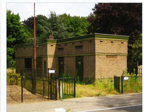
Terwoldseweg, Twello, aan dit transformatorhuisje is een klein werkplaatsje gebouwd
