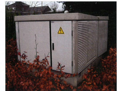
Schakelhuis Twello, HW Iordensweg 1
