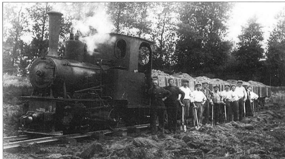
Treintje waarmee de klei uit Welsum gehaald werd. Laden met de schop. Aanvankelijk werden de lorries door paarden getrokken
