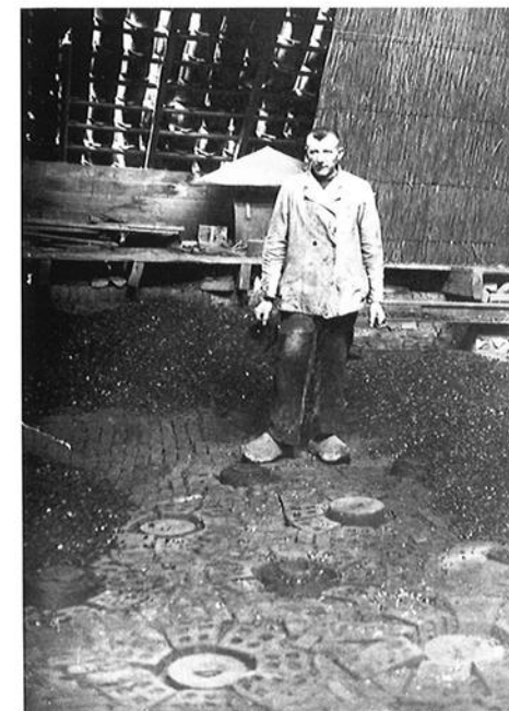
De stoker op de oven. Duidelijk zijn de stookgaten te zien.
