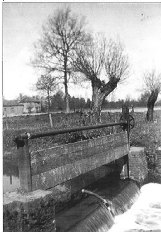
De stuw in de beek en op de achtergrond de molen op de dijk met de molenschuur aangedreven door stroom
