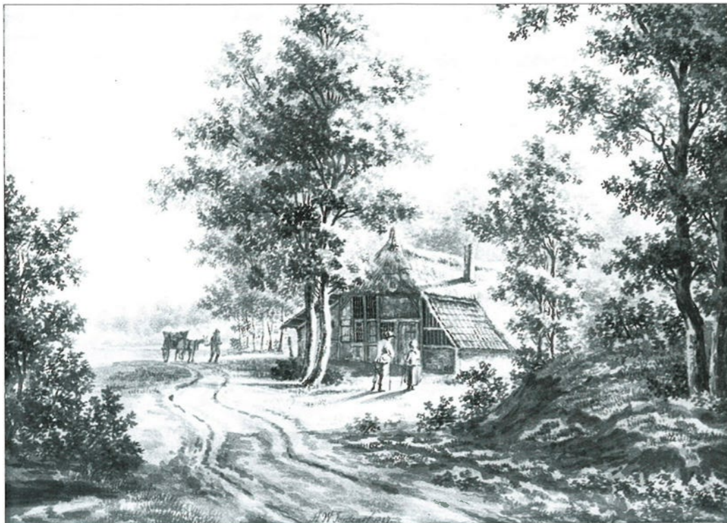
Pentekening door H.W. Jordens, 1827, van mogelijk de boerderij de Poterij, later het Schol. In 1851 vervangen door het landhuis het Schol. Een foto van deze pentekening bevindt zich in het archief van de OKV. Ons overleden erelid L. Sevenster heeft er de volgende tekst bijgezet: "De boerderij de Poterij, die op de belt heeft gestaan en werd afgebroken voor de bouw van de villa Het Schol". De herkomst van de prent wordt niet vermeld; de redactie heeft geprobeerd te achterhalen waar deze zich bevindt, maar is daar niet in geslaagd.
