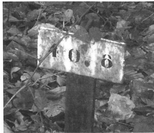
Een zogeheten schouwpaaltje, voorheen door het Waterschap gebruikt om reparatiewerkzaamheden aan de dijk te kunnen laten plaatsvinden.
