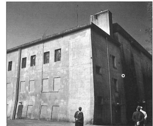
De imposante bunker Diogenes
