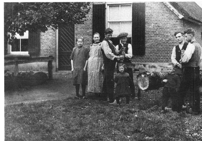
Helpen bij het zagen behoorde tot de eerste werkzaamheden van de leerling.
