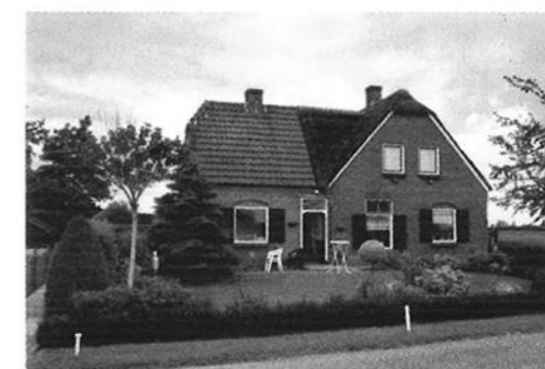
Leemsteeg 24, na de verbouwing van 1960.
