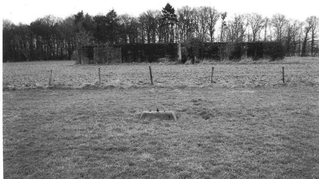
De bunker "Zita" met op de voorgrond een betonnen fundering waaraan de tuidraden bevestigd waren om de mast overeind te houden. (Foto B. ten Bosch).
