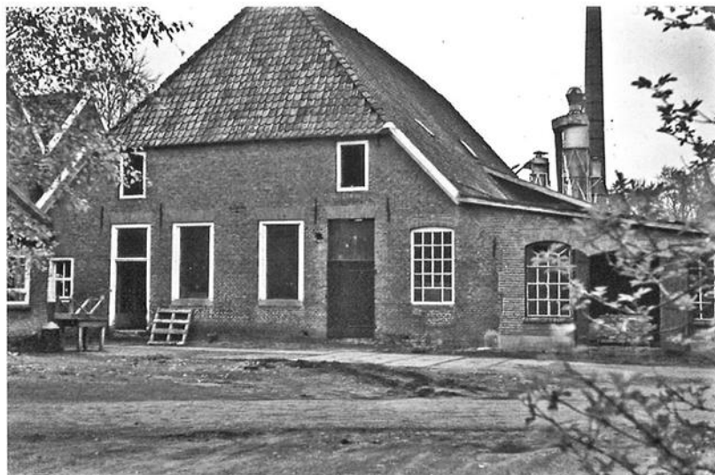
Het gesloopte deel van de fabriek. In het midden is de plaats waar de muurhaak heeft gezeten nog zichtbaar.
