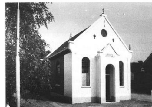
Pniël na de restauratie.
