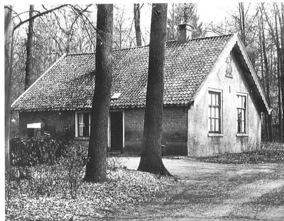
De tuinmanswoning van de Kleine Noordijk in Twello. Links op de foto de drinkwatervoorziening: de waterpomp.
