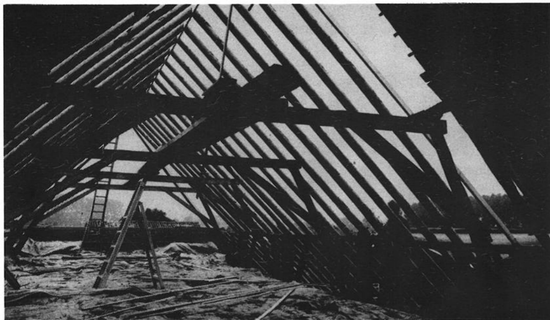
De kapconstructie van de hooizolder met de rondhouten sporen. (Foto coll. L. Sevenster)
