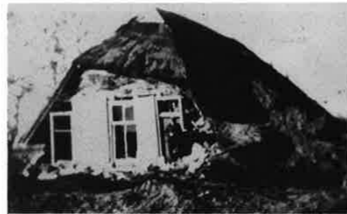
Het vernielde boerderijtje van Jan en Griet Wolters, Zandakkers K111, dat sinds 1940 leeg stond. Het is met de Bevrijding door een Canadese granaat in brand geschoten en niet weer opgebouwd.
