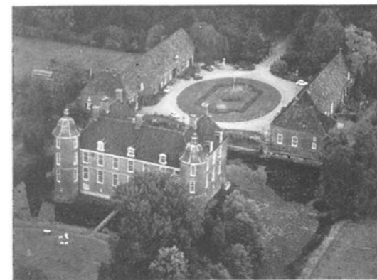
Kasteel Slangenburg in vogelvlucht. Het landgoed Slangenburg, gelegen aan de weg van Doetinchem naar Varsseveld, wordt beheerd door Staatsbosbeheer. In de voormalige paardestal van het kasteel is een informatieruimte ingericht.
