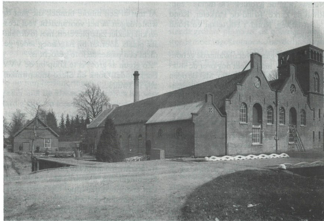
Het exterieur van de fabriek in 1896 met links het turbinegebouwtje en rechts de watertoren. Van hieruit werd een fontein nabij het woonhuis van water voorzien. Het opgepompte water kon zonnodig ook als bluswater gebruikt worden.
